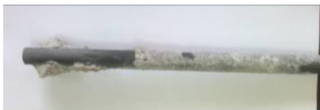
Fig. 10. Debonded CFRP Bar
