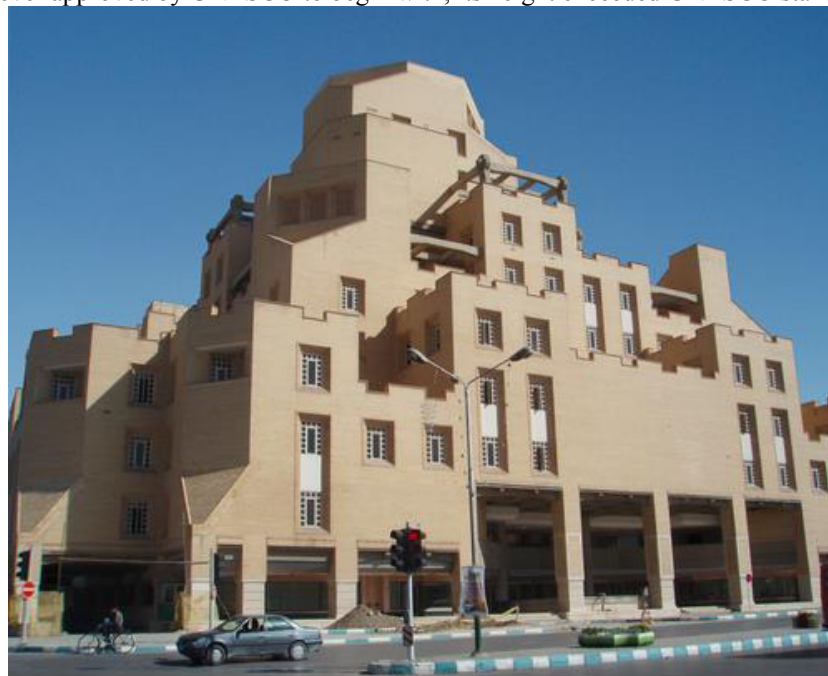
Figure.7: Jahan Nama Tower
