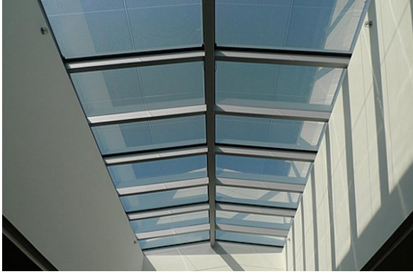
Şekil 4. BIPV Cam Uygulaması
