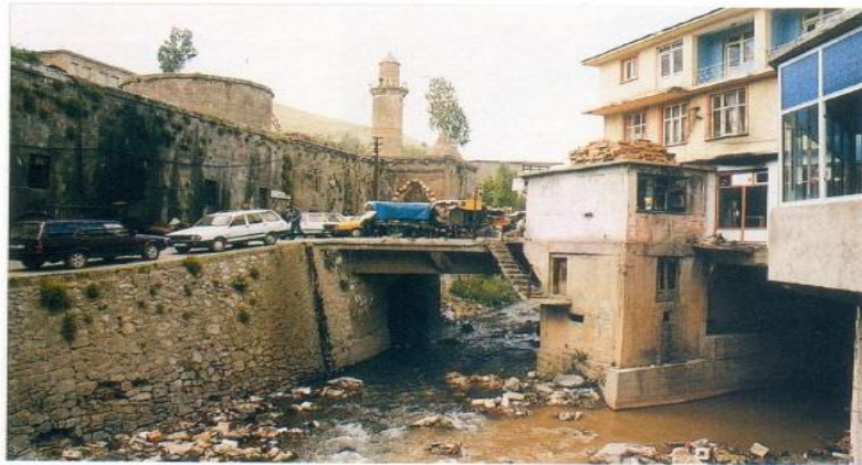
Şekil 3. Bitlis Şerefiye Köprüsü (Serdar, 2013).
