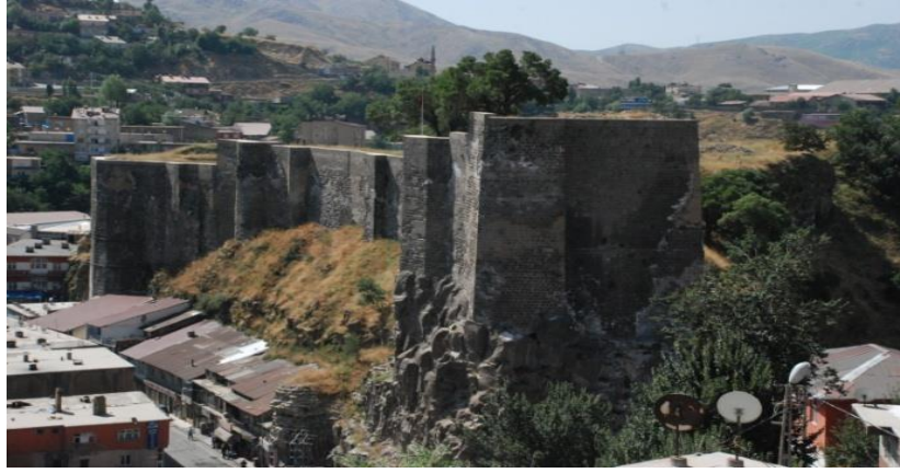
Şekil 7. Günümüzde kalenin Doğu cephesi (Serdar, 2013)
