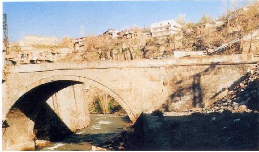
Şekil 4. Bitlis Alemdar Köprüsü(Serdar, 2013).
