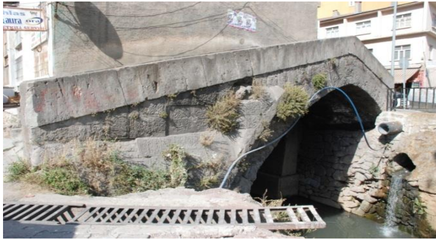
Şekil 5. Bitlis Hatuniye Köprüsü(Serdar, 2013)
