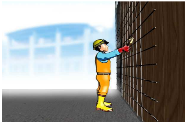
Şekil 1: Kalıbın yağlanması.
