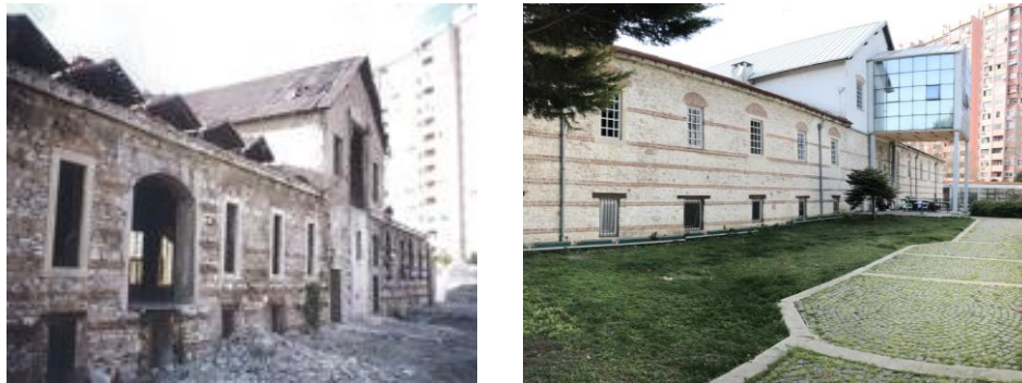
Şekil 5. İspirtohane'nin günümüze ulaşmadığı için çağdaş malzemelerle yeniden yapılan çıkmasının yer aldığı doğu cephesinin restorasyon öncesi (İstanbul 2 nolu KVKK arşivi, 1998) (solda) ve sonrası (sağda) görünümü.
