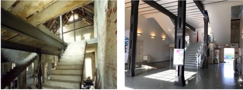
Şekil 4. İspirtohane'nin önceki restorasyonunda özgün volta döşemenin bir kısmı boşaltılarak eklenen betonarme merdivenin restorasyon öncesindeki (solda) (İstanbul 2 nolu KVKK arşivi, 1998) ve sonrasındaki görünümü (sağda).
