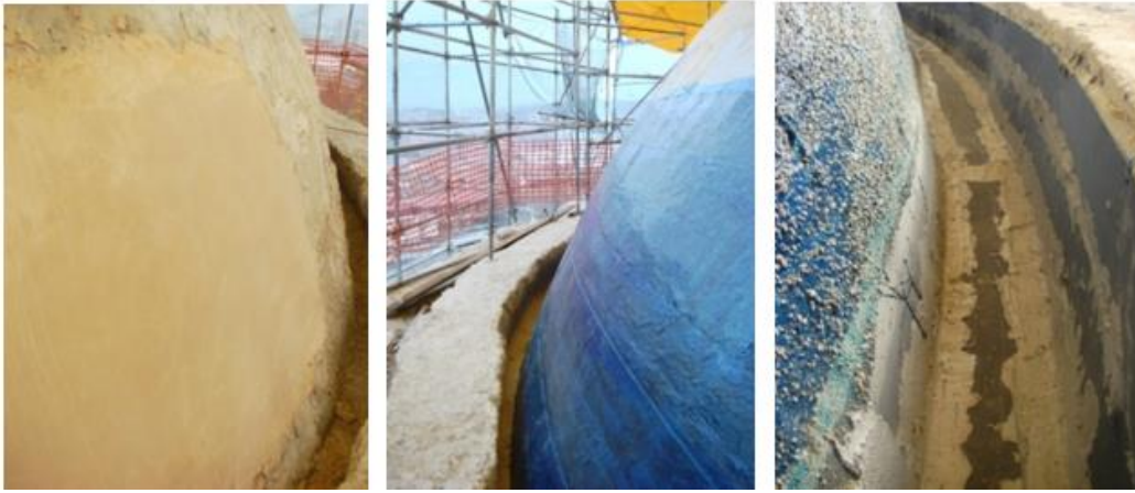
Şekil 12. Mustafa Paşa Camii kubbeye karbon lif uygulaması, 2007 [16]
