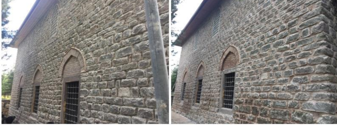
Şekil 2. Ankara Kahramankazan Saray Camii derz açma ve derz işlemi yapılırken, [4]
