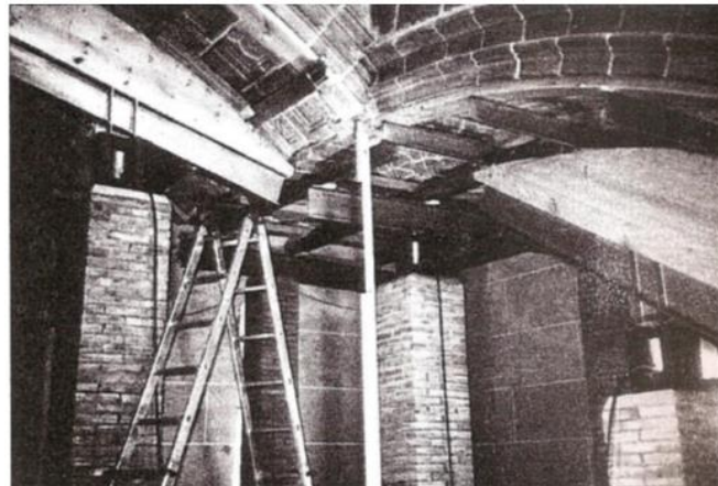
Şekil 24. Monforte Lemos Kardenal Kolejinin merdivenlerindeki deformasyonu düzeltmek için olan geçici strüktür ve krikolar [2]
