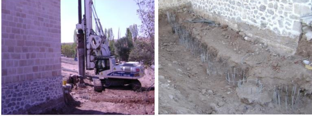
Şekil 31. Kırıkkale Yeşilyazı Camii fore kazık uygulamaları, 2007 [4]
