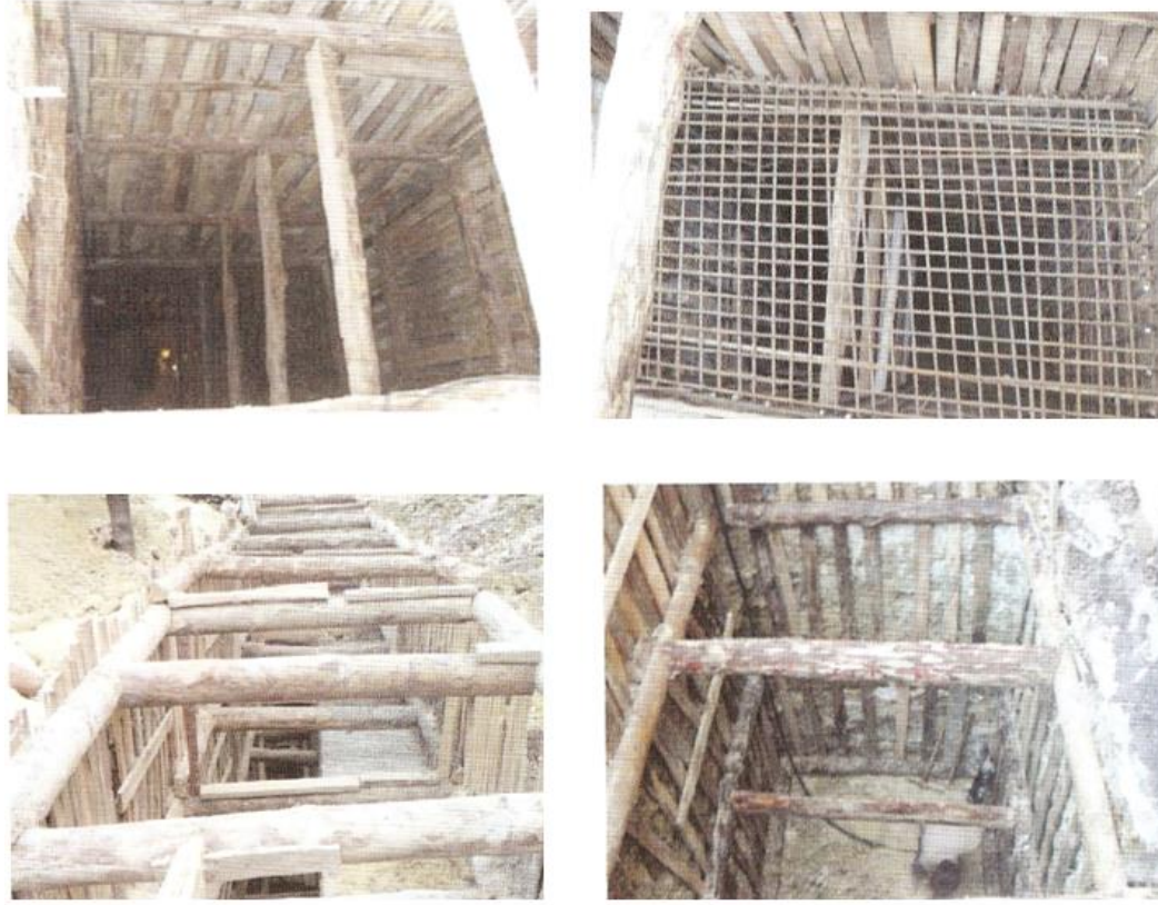
Şekil 26. Edirnekapı Mihrimah Sultan Camii kuyu temel uygulaması [8]
