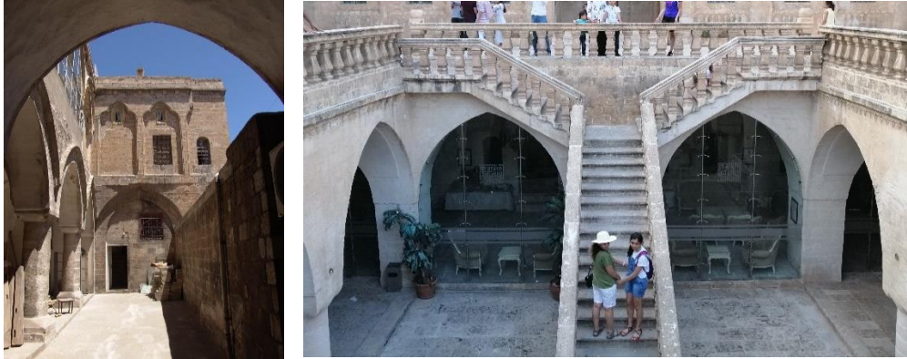
Resim 4: Geleneksel Mardin mimarisinde revak örneği (Mimar Cudi Nas, Mimar Mehmet Topalan ve Mimar Kübra Koçhan arşivinden )
