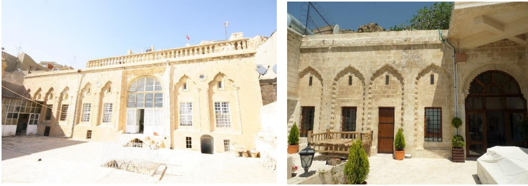
Resim 1: Mardin geleneksel mimarisinde avlu örneği (Mimar Cudi Nas ve Mimar Mehmet Topalan arşivinden )
