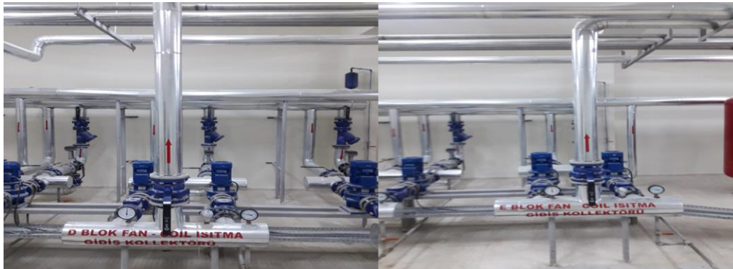
Şekil 2. Enerji ve ekserji analizinin uygulandığı ısı santrali fan coil ve çiller dağıtım sistemi
